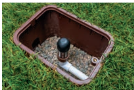
Entlüftungs-/Druckausgleichsventil installiert
